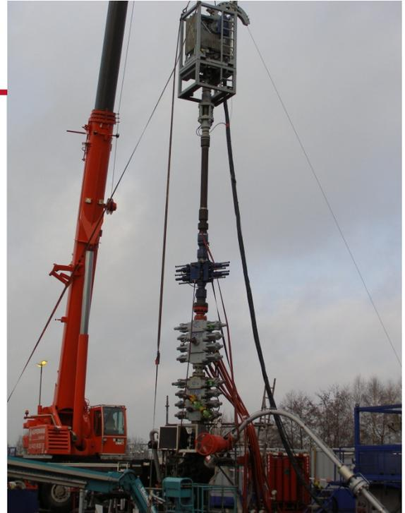
O sistema Renaissance WDCL substituiu de forma eficiente uma TRSSSV danificada em um poço de gás com presença de H<sub>2</sub>S e CO<sub>2</sub>. Usando um equipamento capaz de suportar condições corrosivas no fundo do poço, essa operação ajudou o cliente a evitar as despesas de grandes workovers restaurando a produção a níveis excelentes.
