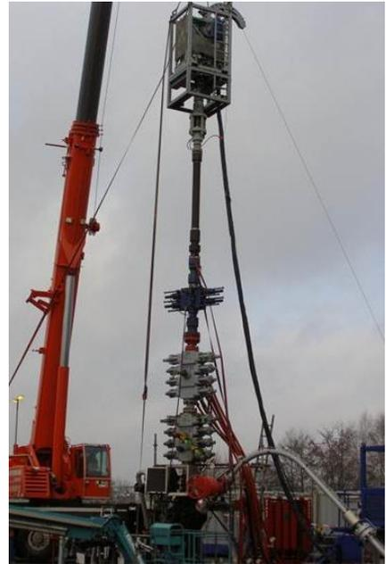
O sistema Renaissance WDCL substituiu uma SCSSV com vazamento em três poços sem usar uma sonda ou requerer intervenções mais complexas. A operação restaurou a produção de óleo às taxas originais em três poços e economizou US \$20 milhões.
